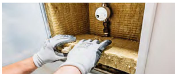
Einrichten einer Revisionsöffnung
