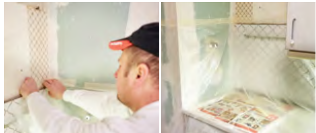
Schutz- und Abdeckmaßnahmen
