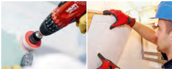
Bohrung der Einblasöffnung
