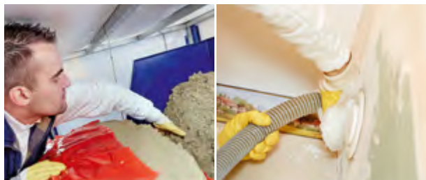
Verfüllung des Etagenschachtes
