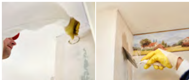
Verschluss der Einblasöffnungen
